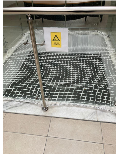
Fotoğraf 13. Düşme tehlikesine karşı galeri boşluğu güvenlik ağı ve uyarı levhası
