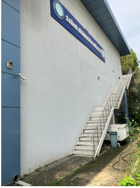
Fotoğraf 11. Fakülte binası dış cephesi ve tahliye merdiveni
