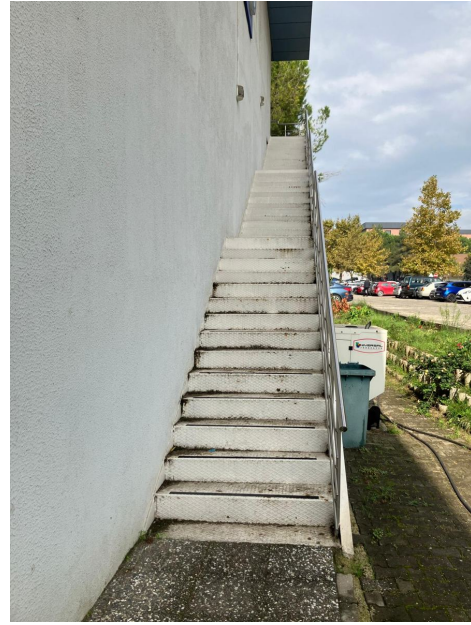
Fotoğraf 10. Bina dışı yangın (tahliye) merdiveni
